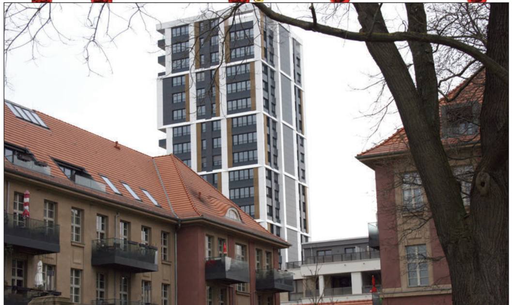
Das 20-stöckige „Haus Ruth“ in der Eschersheimer Straße. Auch die Altbauten im Vordergrund gehören zum Wohnpark St. Marien. Foto: Bothe
